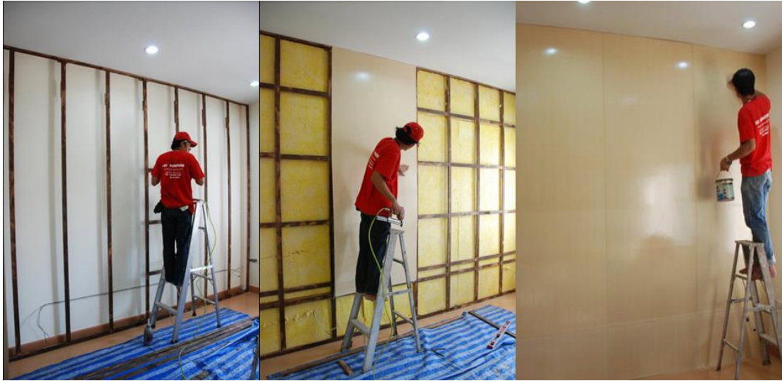
ภาพตัวอย่าง : การติดตั้งฉนวนกันความร้อนที่ผนังด้านใน
